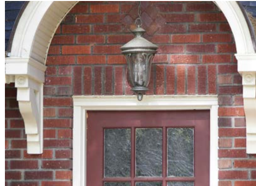
Luminaria decorativa sobre la puerta principal
