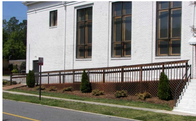
Rampa para discapacitados
