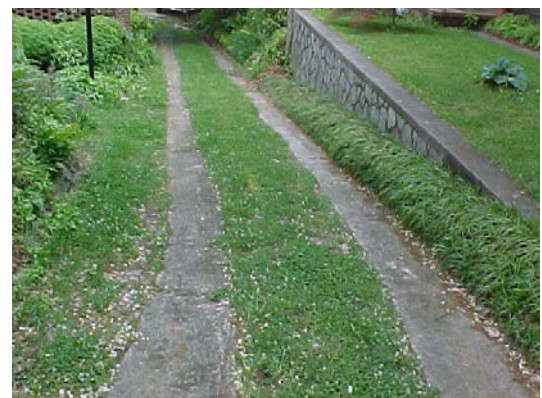
Entrada de vehículos para ruedas de carreta
