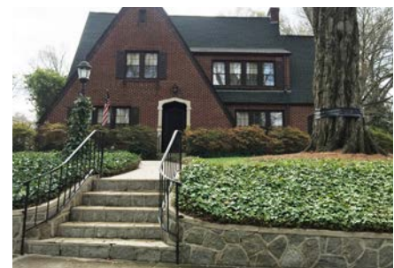
Escalones y muro de mampostería de piedra
