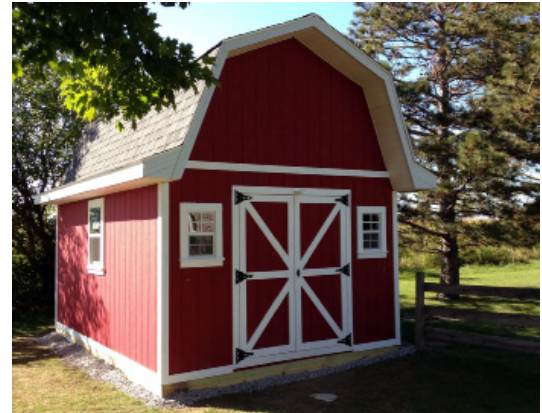
Cobertizo estilo granero inadecuado
