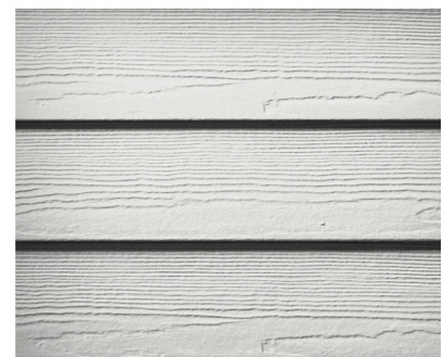
Reemplazo de revestimiento solapado de fibrocemento con revestimiento de madera
